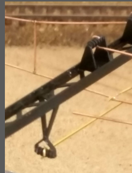
Streckenmast mit Ausleger für zwei Fahrdrächte
